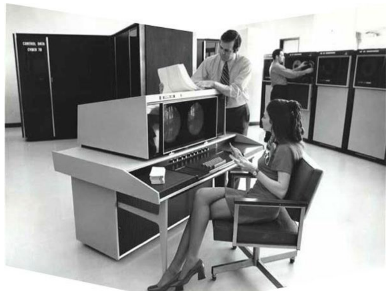
Figura 2. Imagen publicitaria de la computadora central (mainframe) CDC de la serie 70, del tipo que se usaba en el Centro Nacional de Cálculo del Instituto Politécnico Nacional a finales de los años setenta. A la izquierda del teclado pueden verse las tarjetas donde se perforaban las líneas de código, mientras que el hombre sostiene hojas de papel continuo utilizado en las impresoras de matrices de punto, las cuales entonces únicamente podían estampar caracteres alfanuméricos. Fuente: CDC CYBER Photos and CDC Advertising Material. < http://www.control-data.info/photos.html >.
